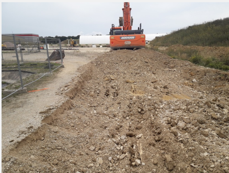
Figure 2 : décapage des matériaux de plateforme
