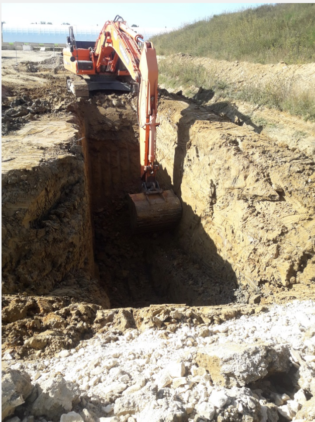
Figure 4 : Début de la tranchée (vue vers le sud)
