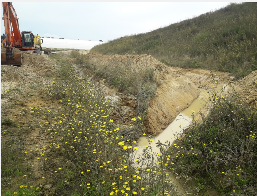
Figure 1 : Vue du canal de détournement des eaux de la zone de travail
