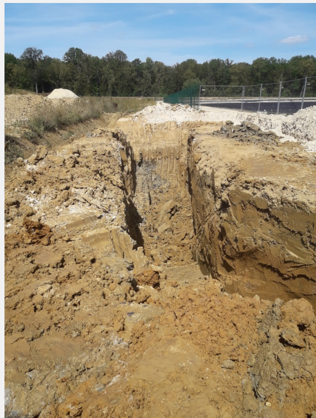
Figure 5 : Changement de l'axe de la tranchée (vue vers le nord)
