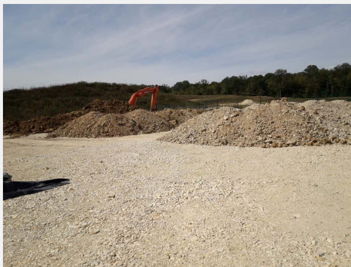
Figure 3 : Aire de stockage des matériaux
